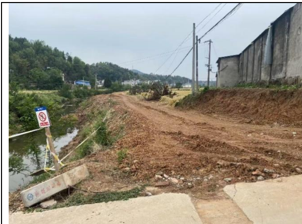
图 2.2-3 已实施 HA0+274 施工便道 3.5m 宽
