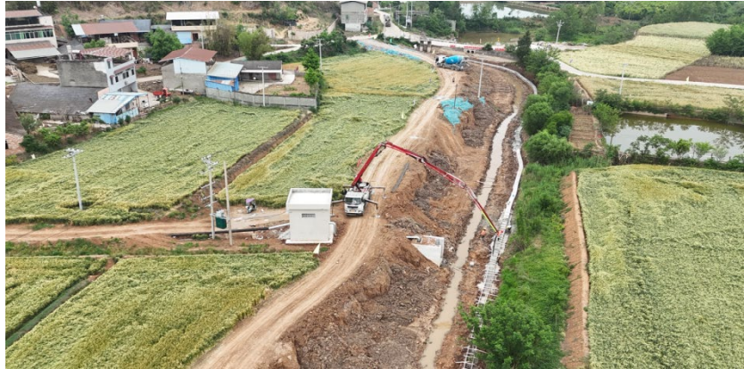
图 2.2-2 河床冠梁浇筑利用便道施工
