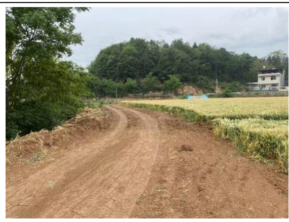
图 2.2-4 已实施 HA0+790 施工便道 4.5m 宽
